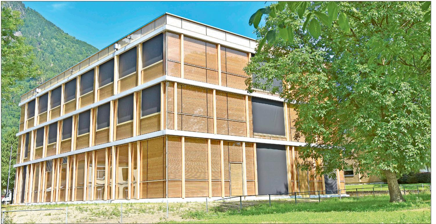
Lucido nennt sich die neuartige Gebäudehülle. Eine thermodynamische Fassade, bestehend aus einem System von Glas und Holzlamellen, dient der Gewinnung von solarer Energie in Form von Wärme. Je nach Stand der Sonne bieten die Lamellen verschiedene Auflageflächen und geben entsprechend Wärme ab oder sorgen für Schatten und damit kühlere Temperaturen.
